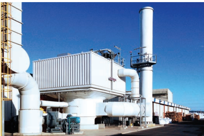
RNV mit Drehschieberteknik bietet den Vorteil minimaler Druckschwankungen.
